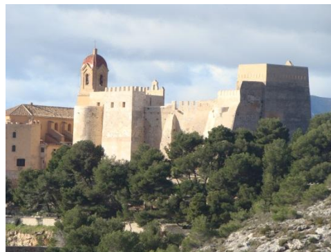
Fig. 6- Fachada oriental de la Fortaleza, a la derecha e Baluarte defendiendo el acceso a la Torre Major
